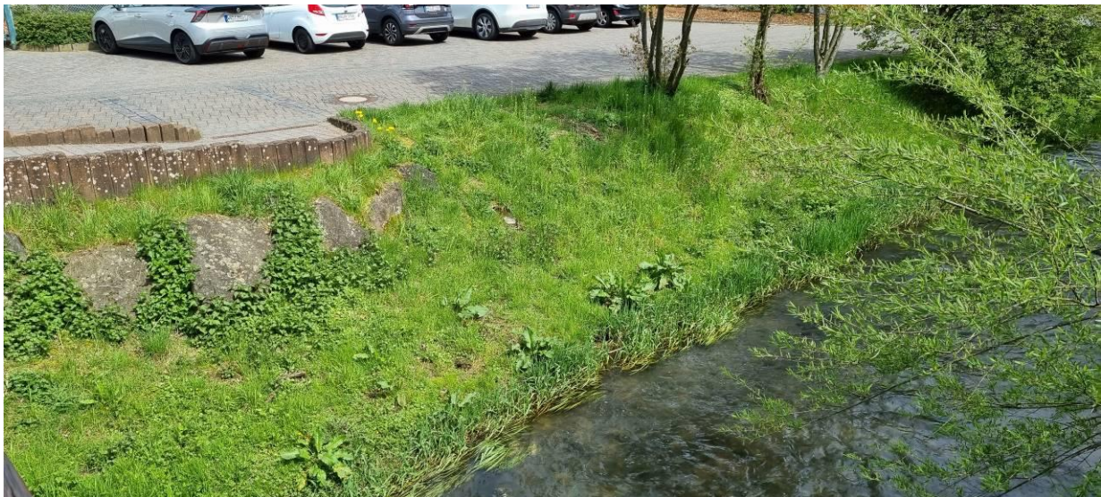
Foto 3: Stützmauern im Uferbereich der vorhandenen Brücke am Parkplatz der VG
