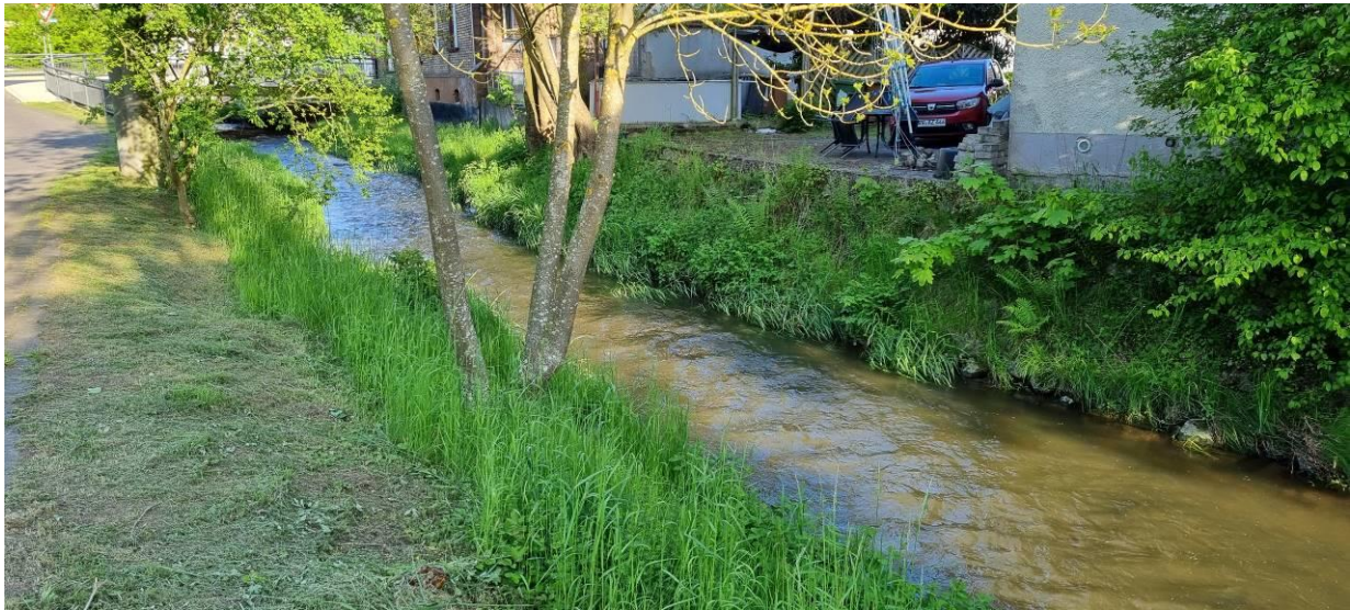
Foto 9: Gebäude und Stellfläche im unmittelbaren Uferbereich des Saynbaches, das nach Rücknahme der Baufläche im B-Plan beseitigt würde.
