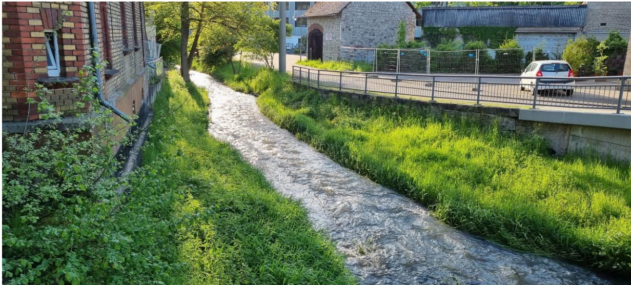
Foto 6: Starker Uferverbau am Saynbach im Stadtgebiet von Selters
