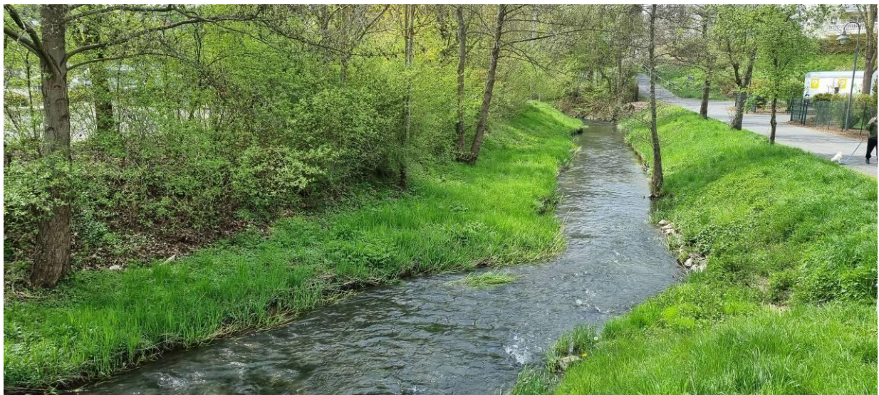
Foto 2: Begradigter Gewässerverlauf des Saynbaches innerhalb der Ortslage von Selters unterhalb der bestehenden Brücke
