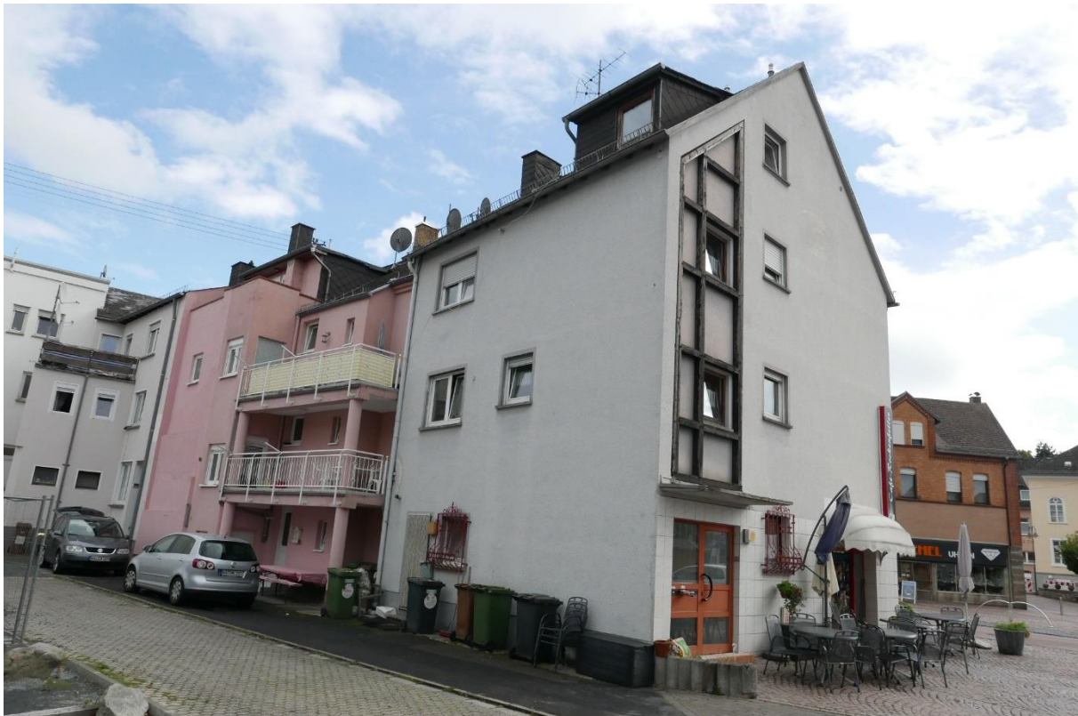
Abb. 5: Blick auf die Bestandsbebauung im Südosten des Plangebiets
