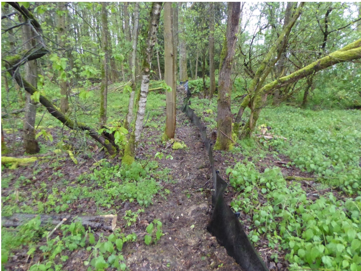
Abbildung 11: Aufgestellter Amphibienzaun um den Eingriffsbereich
