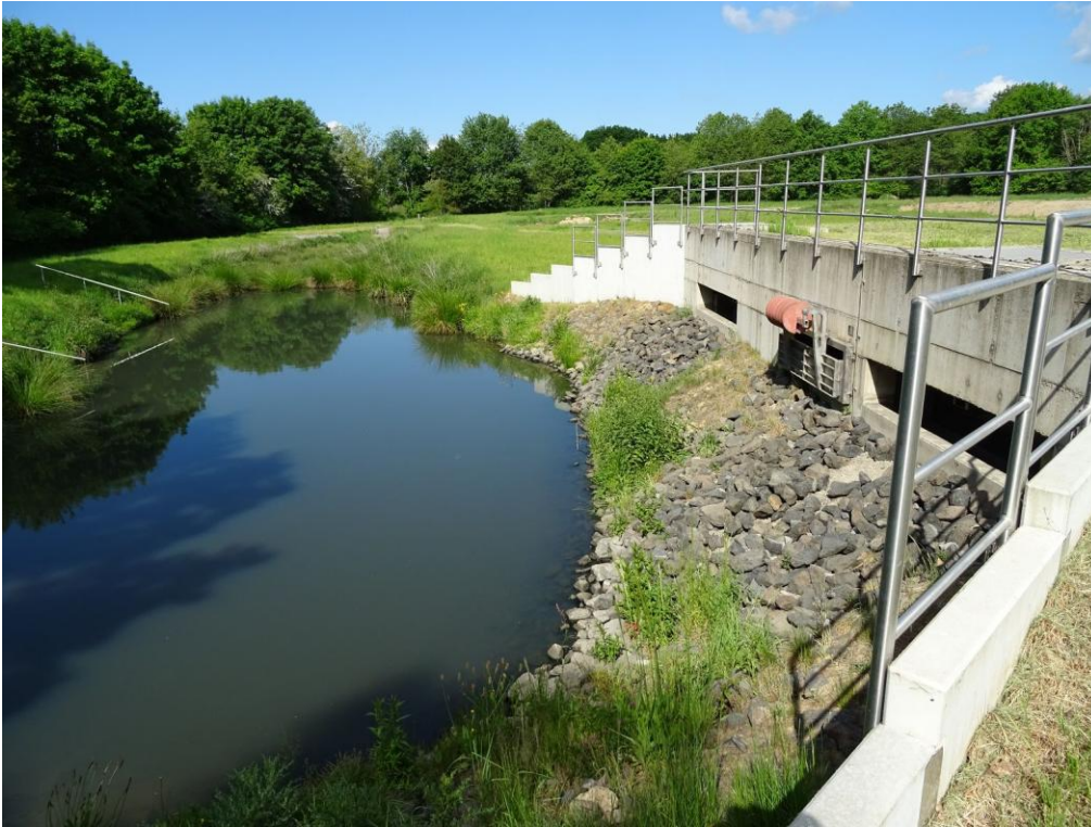
Foto 6 Blick nach Westen über den ehemaligen Schönungsteich, nun Regenrückhaltebecken mit Sedimentationszone, Stand Mai 2025
