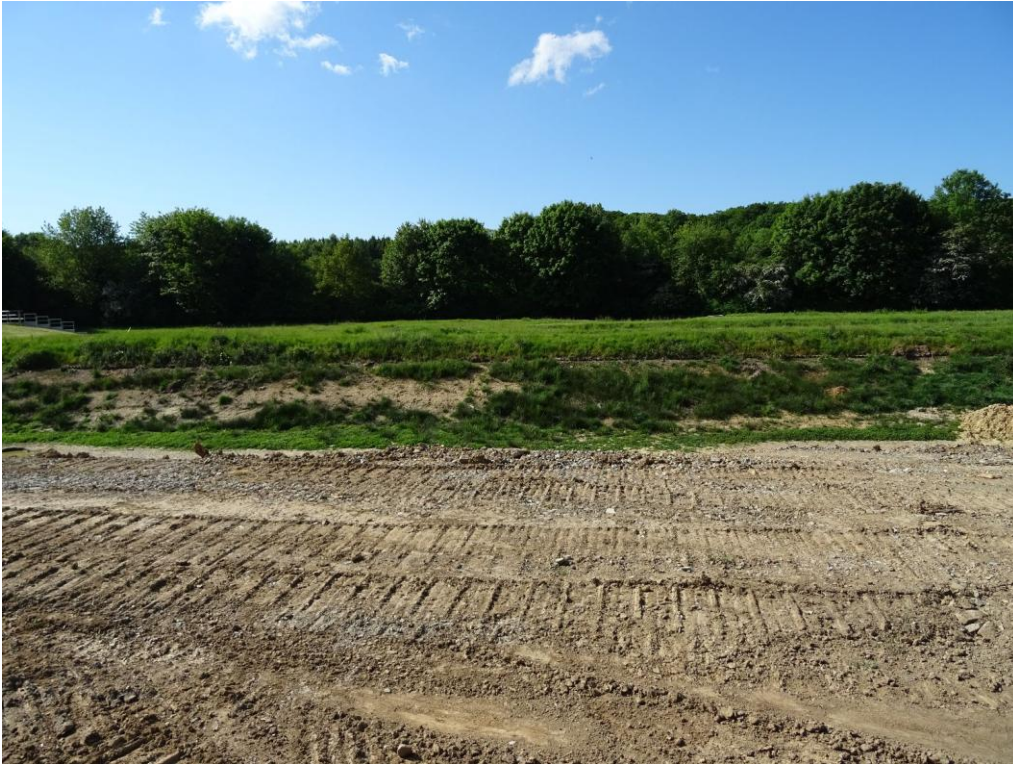
Foto 4 Blick nach Süden über die Kläranlage, Stand Mai 2025
