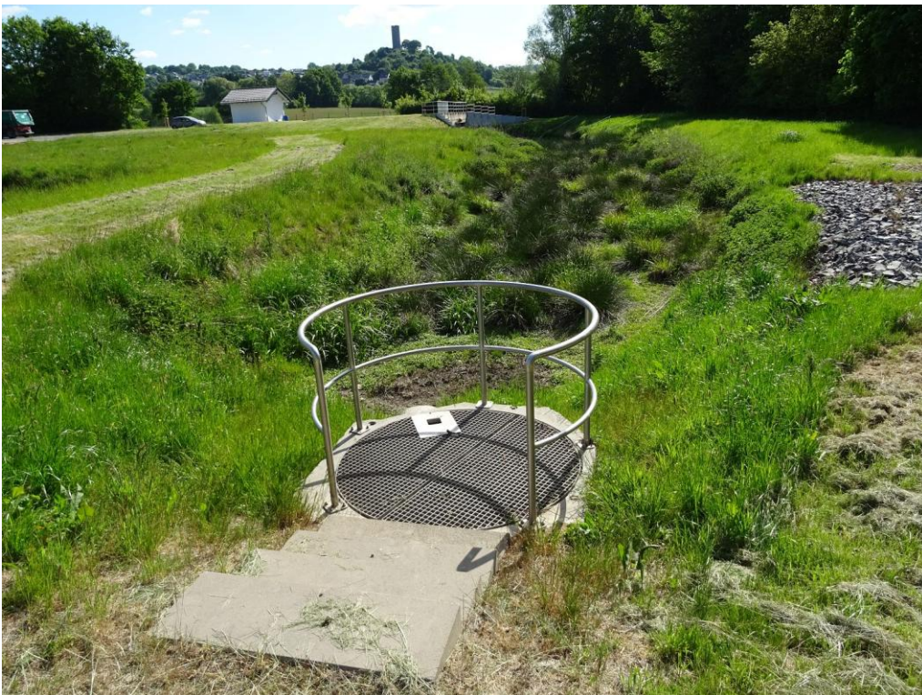
Foto 5 Blick nach Osten über den ehemaligen Schönungsteich, nun Regenrückhaltebecken mit Sedimentationszone, Stand Mai 2025
