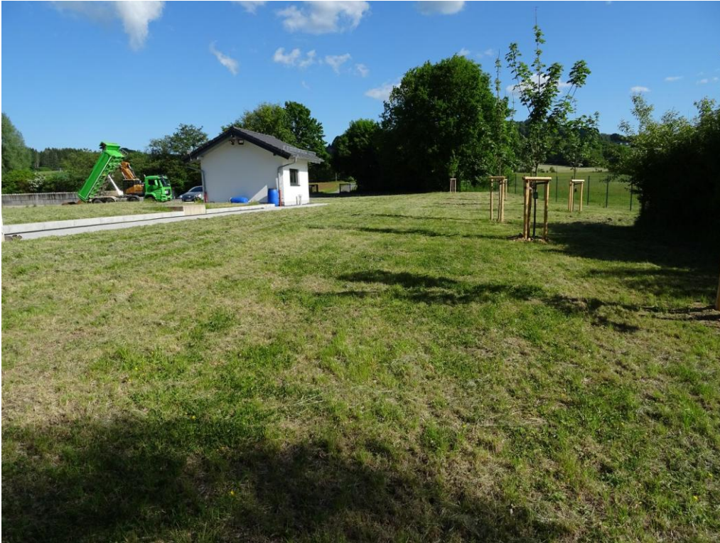
Foto 2 Blick nach Norden auf das Abwasserpumpwerk mit unterirdischem Regenüberlaufbauwerk
