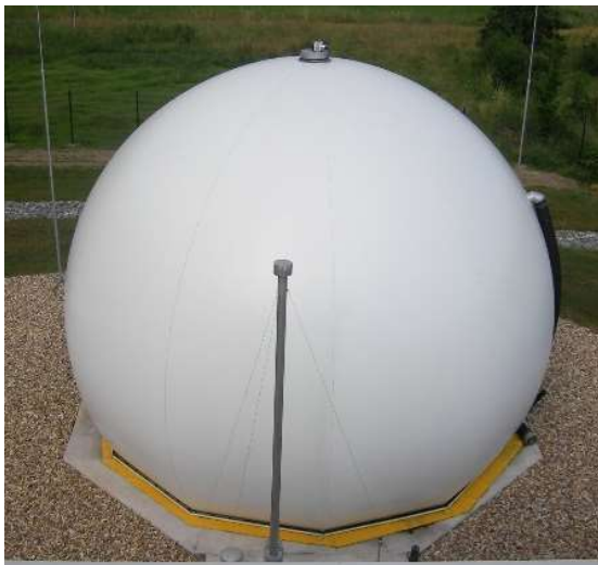
Abb. 11: Doppel-Membran-Gasspeicher
