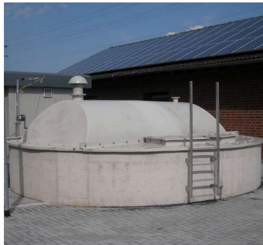
Abb. 8: Rohschlammbehälter
