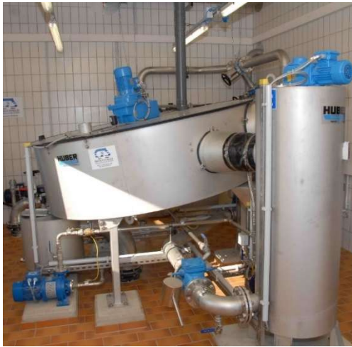
Abb. 9: Mechanische Schlammmeind-ckung
