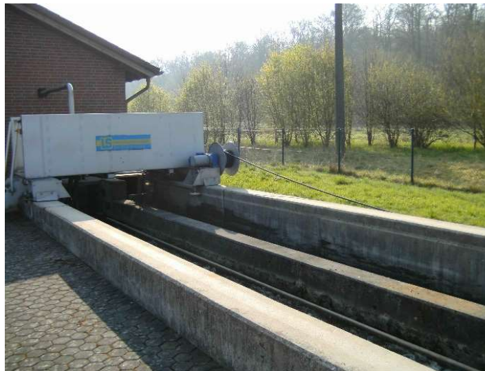
Abb. 4: Langsand- und Fettfang
