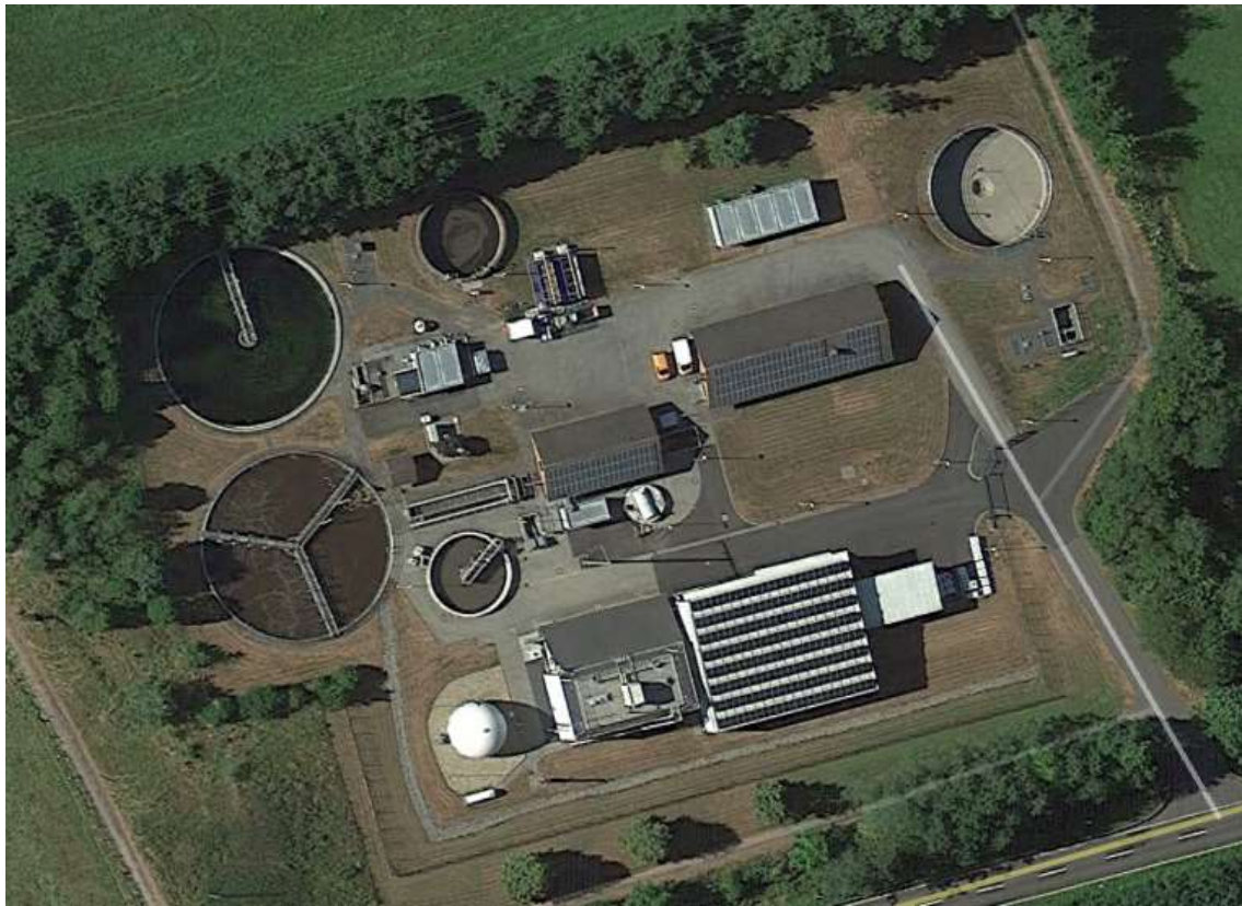
Abb. 2: Luftbild Kläranlage Selters
