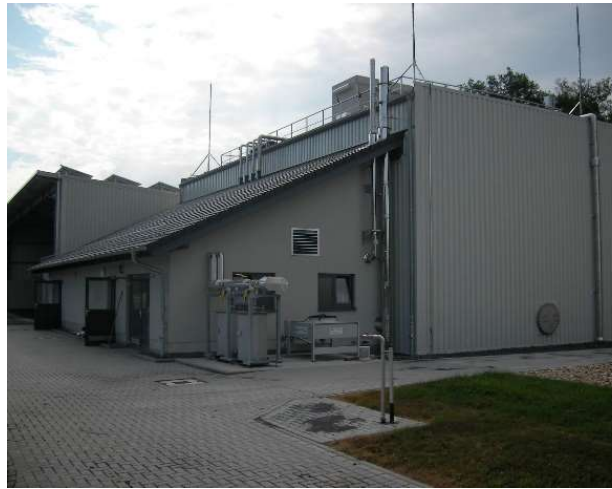
Abb. 10: Kompaktfaulung mit Technikgebäude
