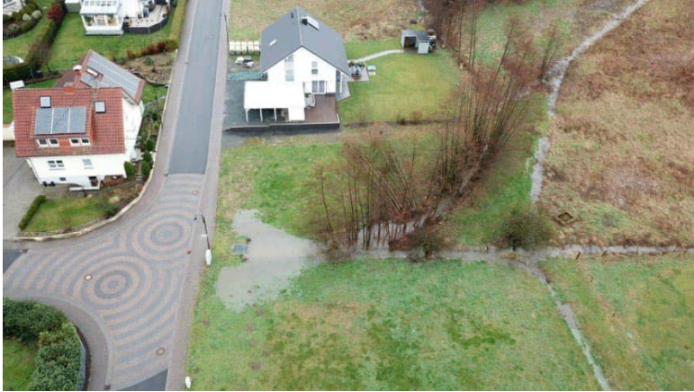
Abbildung 12: Einlaufbauwerk des Quardbachs bei Hochwasserereignis 2019
