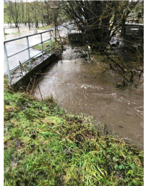
Abbildung 13: Brücke über Mühlbach nordwestlich der Vielbacher Mühle bei Hochwasserereignis 2021, im Hintergrund ist Abfluss aus Kleinem Saynbach zu erkennen, welcher teils über die Straße in den Mühlbach entwässert.
