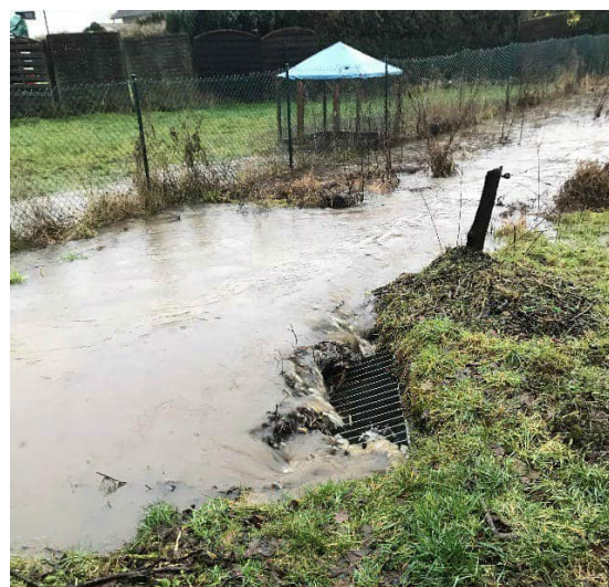
Abbildung 18: Notablauf des Mühlbachs unterhalb der K133 bei Hochwasser 2021
