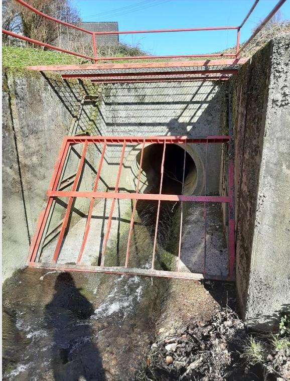
Abbildung 30: Einlauf Verrohrung „Steinchesbach“
